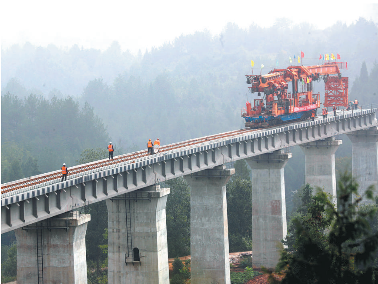
10月29日,在渝怀铁路二线重庆跨江段刘家院子特大桥上,中铁十一局工作人员在架设桥梁。渝怀铁路二线是国家中长期铁路网规划的重要建设项目,是川渝地区连接我国华中、华南地区重要的铁路运输通道。该线路在既有渝怀铁路旁新建,全长625公里,设计时速120公里。目前工程进展顺利,全线有望明年建成通车。杨 敏摄(中经视觉)
