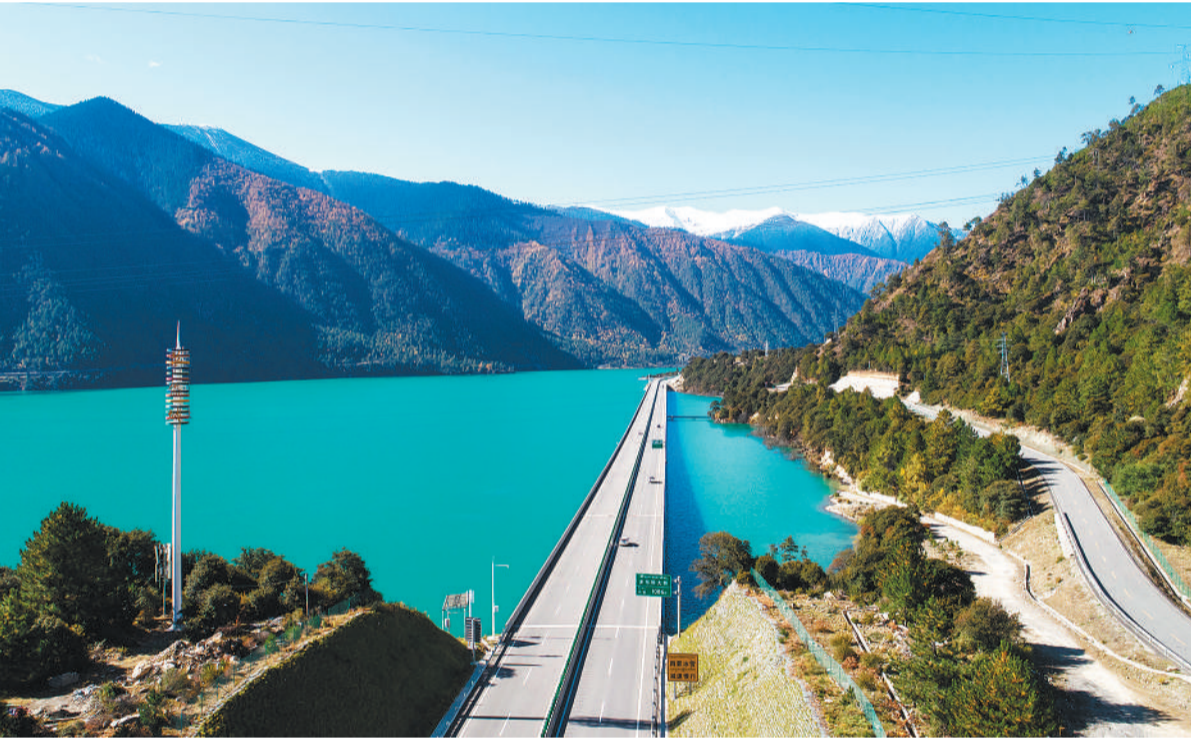
西藏拉林高等级公路上的“最美大桥”
