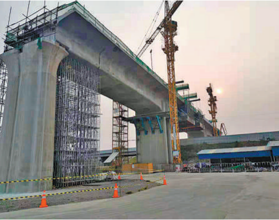
印度尼西亚雅万高铁项目全线首座连续梁日前顺利合龙，为后续箱梁架设和铺轨工作奠定基础。图为即将合龙的首座连续梁。（新华社发）
