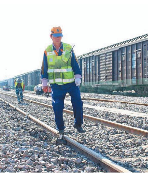
在货物列车解体作业中,下峰车辆的调速非常重要,欧阳强每天的工作就是检修减速顶。他的方法主要是用脚踩。
