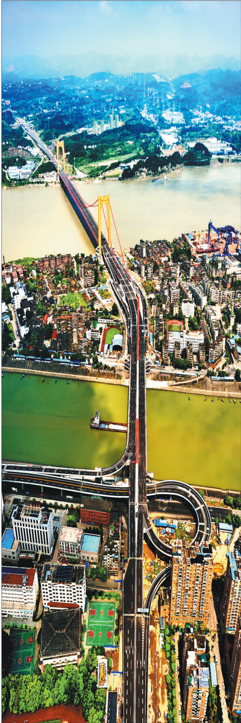
▼宜昌至喜长江大桥位于中华鲟核心保护区范围内,该桥采用一跨过江方案,不在水中建桥墩,既使中华鲟洄游不受影响,也保证了长江航道不阻航、断航,有效保护了周边环境和长江珍稀动物多样性。刘曙松摄
