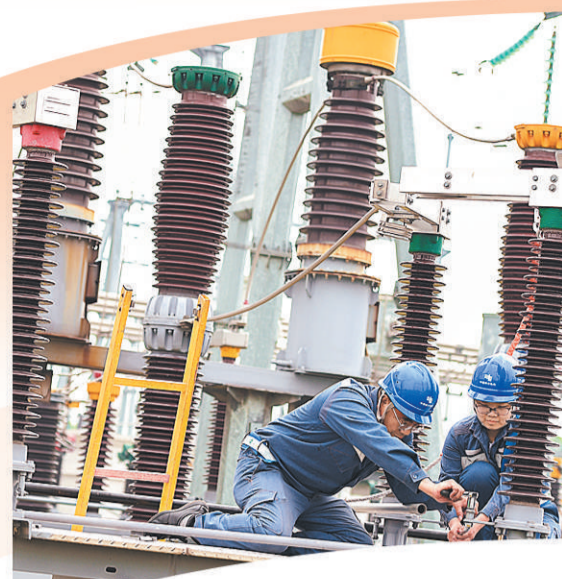
东莞供电局板桥培训基地变电高压设备实训场隔离开关检修平台工人在培训。新华社记者 刘大伟摄
