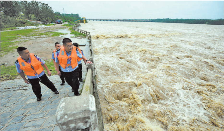
8月12日,值班民警在沂河山东省临沂市郯城县马头镇段拦河闸巡逻。当日,该段拦河闸开闸泄洪,流量达每秒5870立方米。
