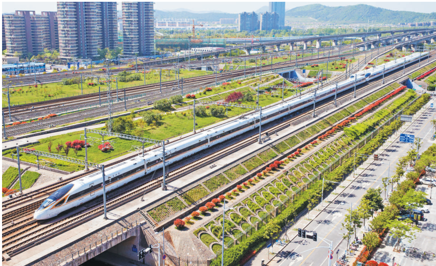
—列“复兴号”动车组行驶在京沪高铁南京市境内。
