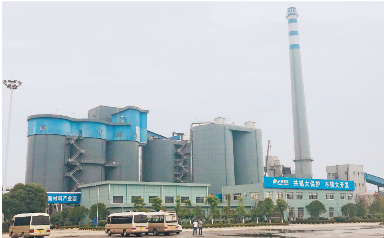
为了“共抓大保护,不搞大开发”、破解“化工围江”问题,在湖北省政府的指导下,全国最大的精细磷化工企业兴发集团从2017年开始就对园临江生产设施实施拆除或整体搬迁,关闭了排污口,并对拆除区域全面绿化。图为转型后的兴发集团宜昌新材料产业园。
