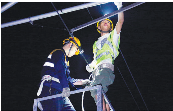
7月17日凌晨,中国铁路郑州局集团公司新乡供电段工作人员在检查接触网零部件。暑运期间,新乡供电段加大检修力度,提高检修效率,确保管内高铁运行安全畅通。 高国桥摄(中经视觉)
