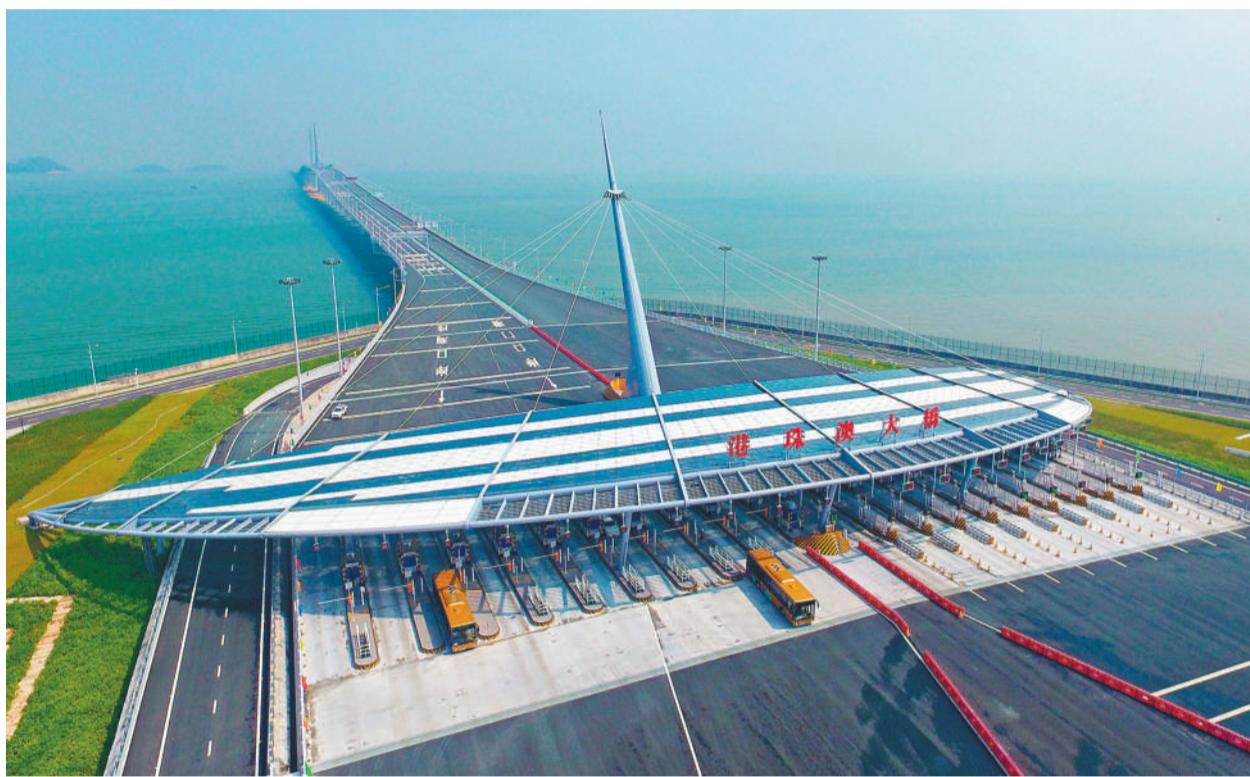
2018年10月建成开通的港珠澳大桥,有力促进了粤港澳大湾区发展,也为广东高质量发展注入了新动力。
