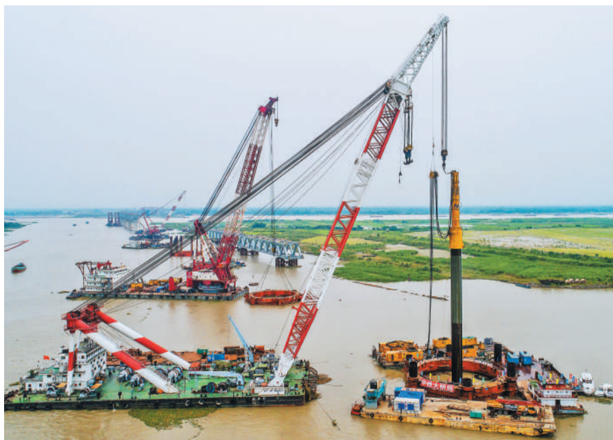
7月15日,孟加拉国帕德玛桥主桥钢桩全部插打完成。 欧阳耀坤摄
