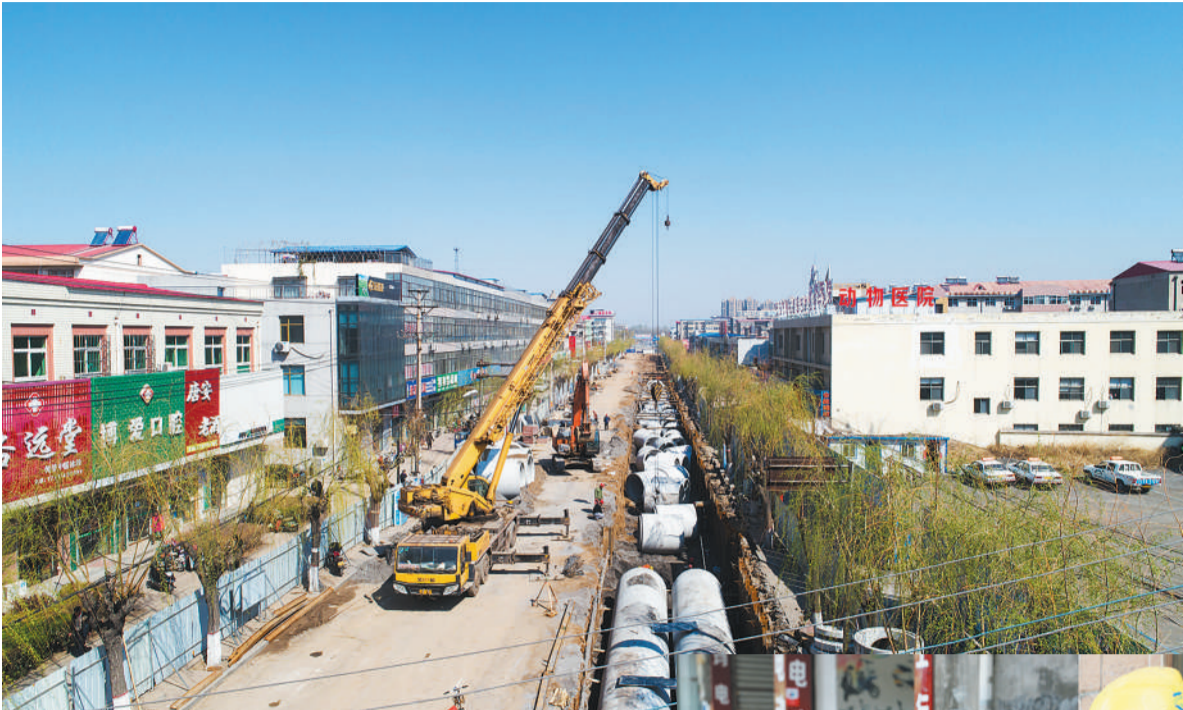
上图 河北省迁安市是海绵城市建设试点县级市,2017年以来,该市实施了189个海绵工程,通过渗、滞、蓄、净、用、排等工程设施,86%的主城区实现海绵化改造。图为当地海绵城市工程建设施工现场。 陈 儒摄(中经视觉)
