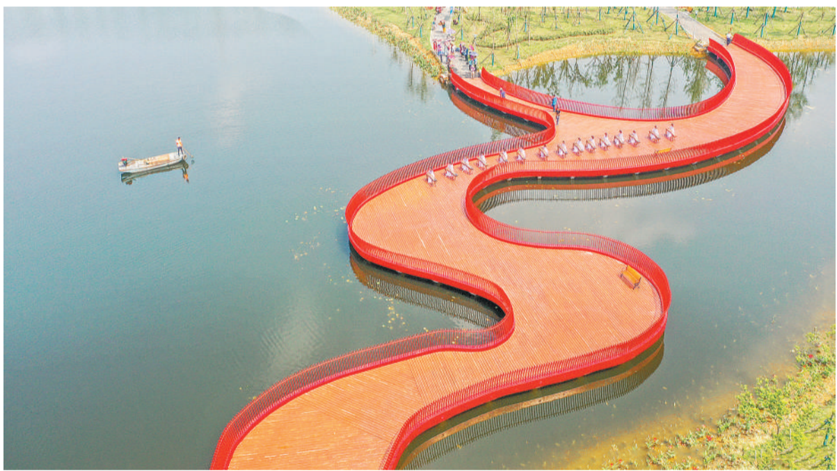
7月11日，江苏省宿迁市泗洪县城北污水处理厂旁的尾水湿地公园，蓝天碧水、生机盎然。近年来，泗洪县大力开展污水防治，全县城区已建成城南、城北两座污水处理厂，并在污水处理厂边，对达标排放的尾水进行再次进化提质，科学建设生态湿地，打造尾水湿地生态公园。
