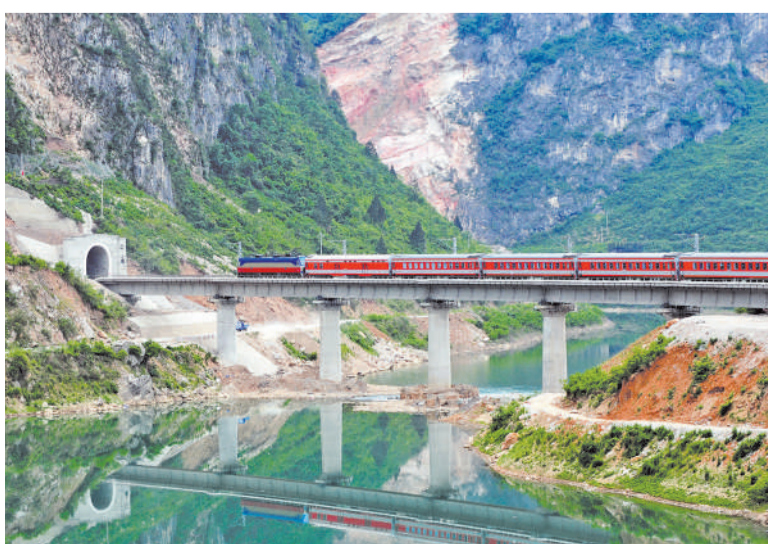
2009年5月8日,一列旅客列车即将通过宝成铁路新109隧道。
