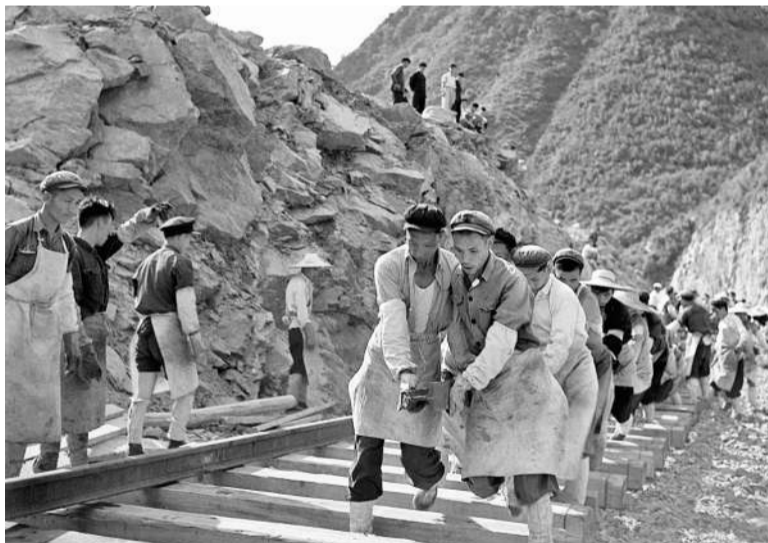
1955年,宝成铁路工人在紧张地铺轨。
