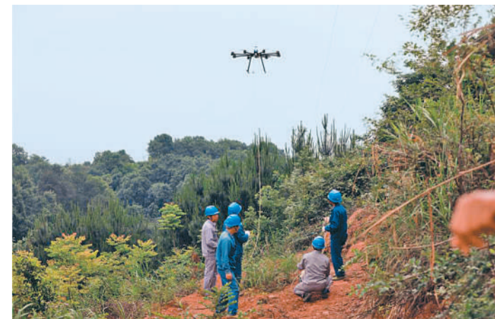
在湖南常德理公港南岳殿村电力施工现场，施工队员采用无人机+张力放线技术架设ADSS光缆，节约了大量时间成本和人力成本。易兵摄(中经视觉)
