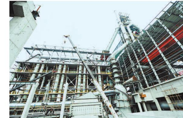
6月29日,位于山西省曲沃县的晋南集团立恒钢铁1860立方米高炉正在加紧建设中。立恒钢铁按照“减量置换、装备升级、环保优先”的原则,投资近百亿元升级改造建设2座1860立方米高炉及配套2座150吨转炉,采用智能化生产工艺,推进超低排放改造。
