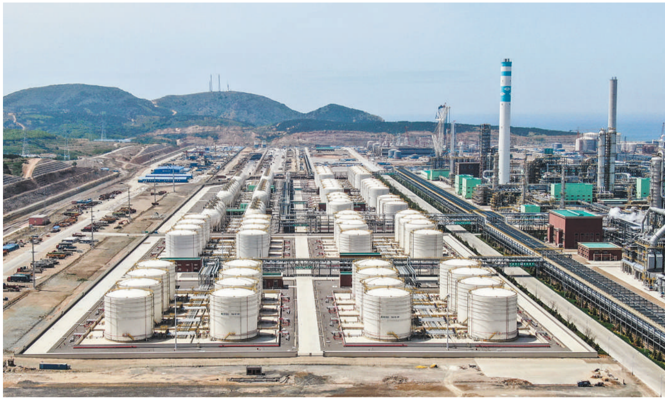
恒力2000万吨/年炼化一体化项目在辽宁省大连市长兴岛正式建成投产。
