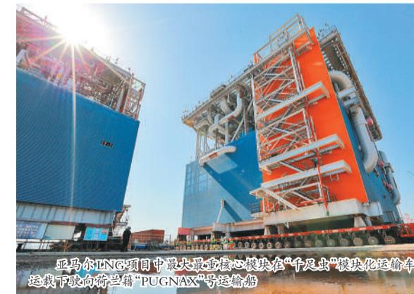
亚马尔LNG项目中最大单体核心模块在“千足虫”模块化运输车的运载下驶向荷兰籍“PUGNAX”号运输船
