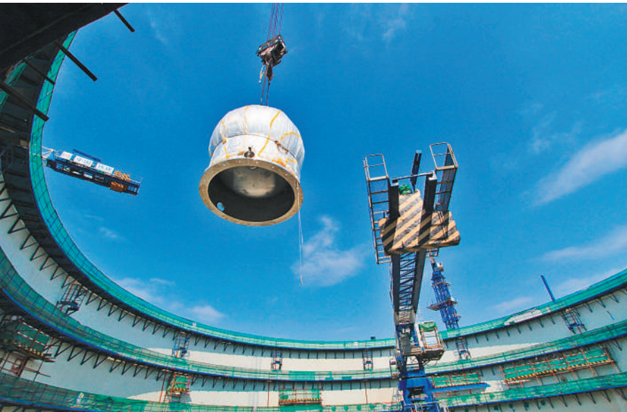
福清核电6号机组安注箱吊装现场。
