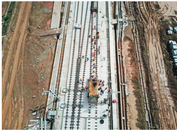
图为昌赣高铁完成全线铺轨贯通。丁波摄（中经视觉）
