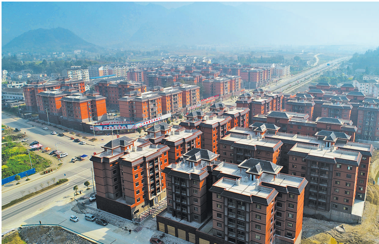
贵州省绥阳县风华镇虹桥社区易地扶贫搬迁安置点。
