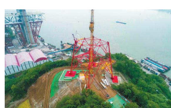
4月28日，施工人员在镇江长江段五峰山南岸组立安装220千伏输电线路跨江铁塔。
