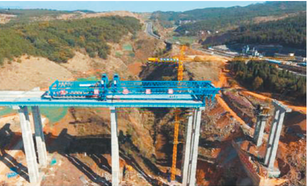
中铁工业九桥公司研发的大跨度装配式钢混组合简支梁技术与装备在寻沾高速小龙潭大桥成功应用。(资料图片)
