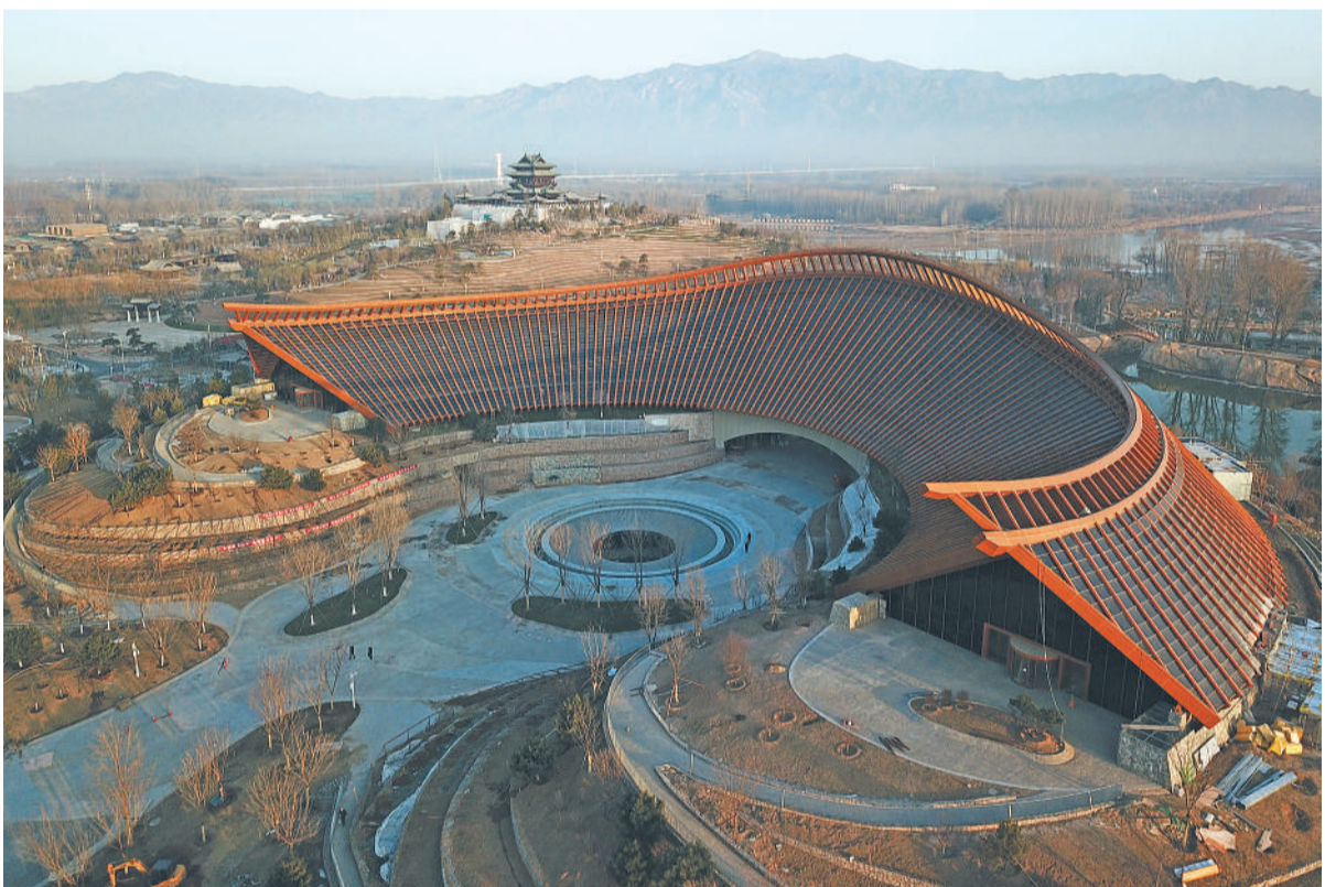
截至3月28日，北京世园会园区建设工作已进入冲刺阶段，园区基本成形，公共区域主要建筑全面完工，室内布展正在进行中。图为3月27日无人机拍摄的中国馆。
