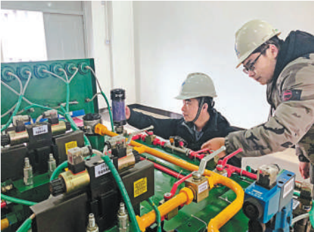
2月19日,在河北易县南水北调北易水倒虹吸出口节制闸,机电设备管理人员对主油箱进行例行巡检。
