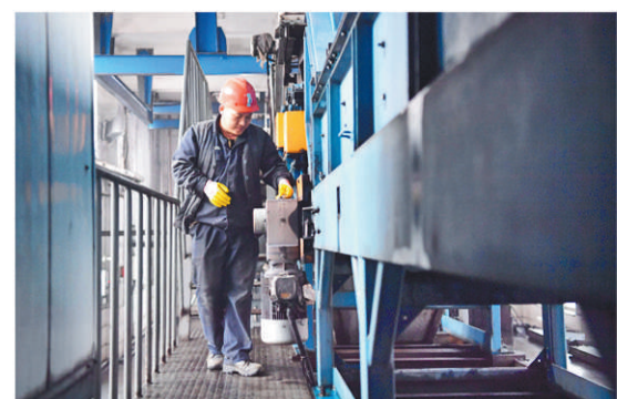
鲁西煤矿CXR智能干选车间，机电工区维修工张涛正在巡检设备。
