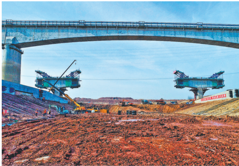
3月16日,引江济淮工程安徽庐江县庐铜铁路交叉河渠段,施工人员进行关键性控制工程一级边坡灌浆浇筑。庐铜铁路交叉河渠段是引江济淮工程(引江济巢线)菜子湖线段的一部分。目前,该线段已率先完成河道基础施工,进入关键性控制工程一级边坡灌浆浇筑。王 闯摄(中经视觉)
