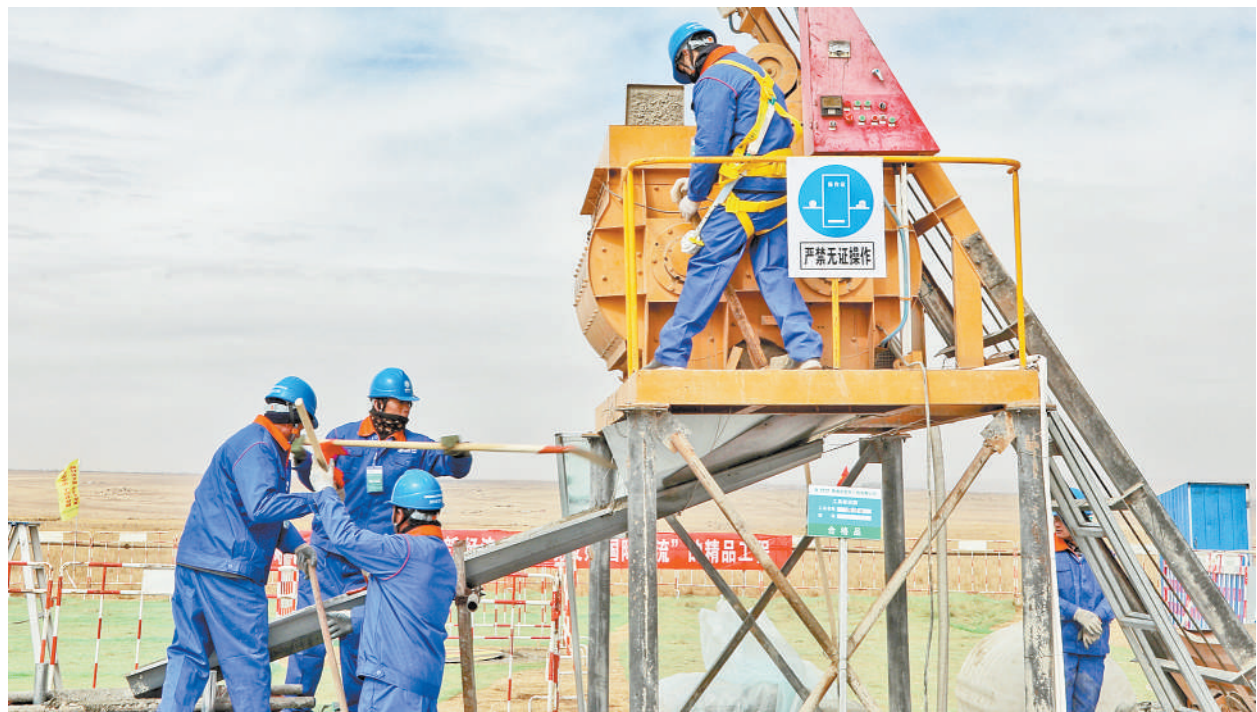
2月20日，施工人员在青海—河南±800千伏特高压工程现场作业。该工程遵循“样板引路、试点先行”的科学管理理念，在基坑开挖过程中采取了挖孔方式，每个基坑的直径只有不到3米，对确保工程建设质量和环境保护具有重要意义。
