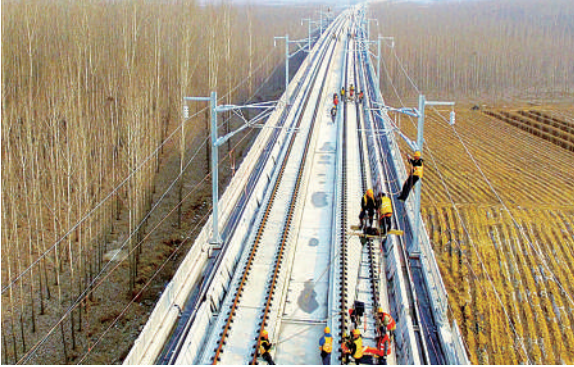
2月21日,中铁电气化局装备公司员工在鲁南高铁临曲段进行接触网导线作业。鲁南高铁建成后,将有力推动当地经济发展。 武冠群摄(中经视觉)
