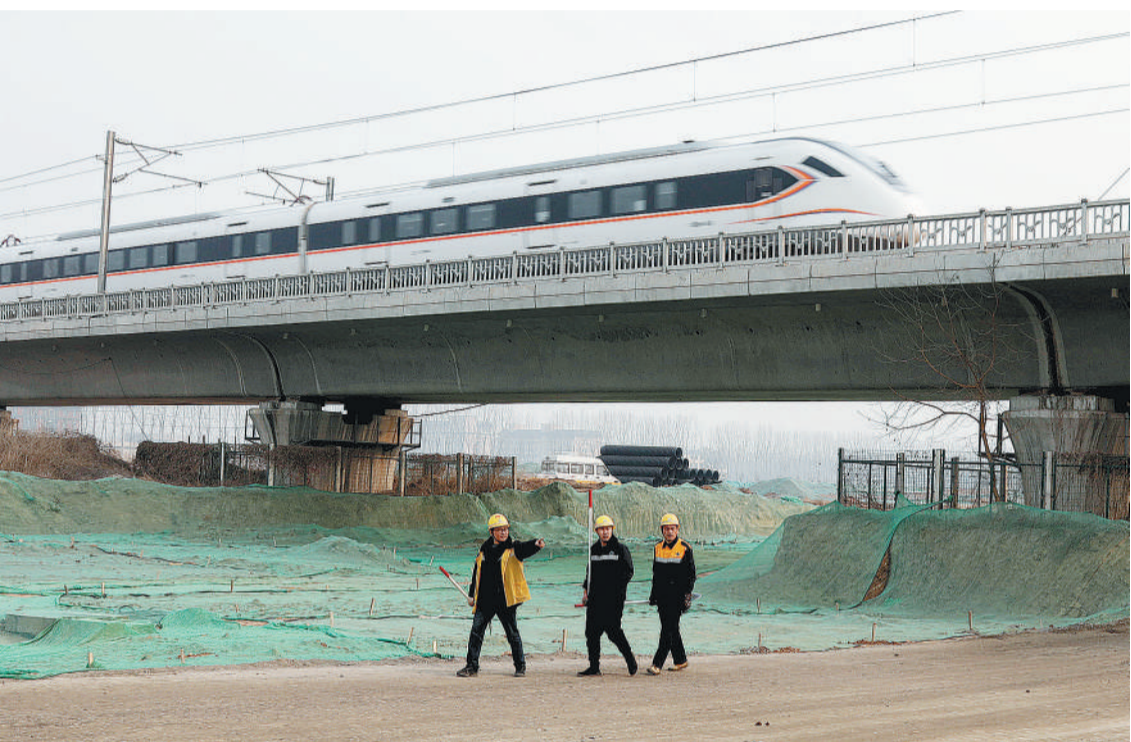
2月15日,中国铁路郑州局集团有限公司新乡供电段员工在铁路沿线巡查。进入春运以来,列车密度加大,接触网设备满负荷运行。为保证列车安全和不间断供电,新乡供电段员工每天在铁路沿线巡查,排除一处安全隐患。高国桥摄(中经视觉)
