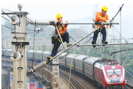
2月6日,中国铁路南昌局集团有限公司南昌供电段的职工在武九铁路南昌段检修保养接触网设备。
