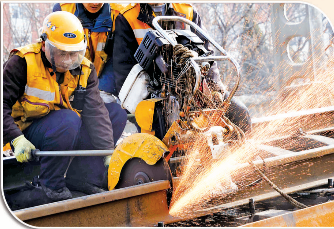
上图 2月5日,中国铁路郑州局集团有限公司郑州桥工段的职工在切割钢轨。 新华社记者 李安摄
