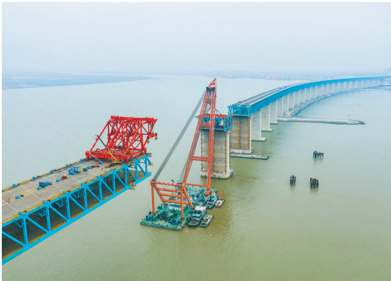
沪通长江大桥主航道桥墩顶钢梁架设施工全部完成
