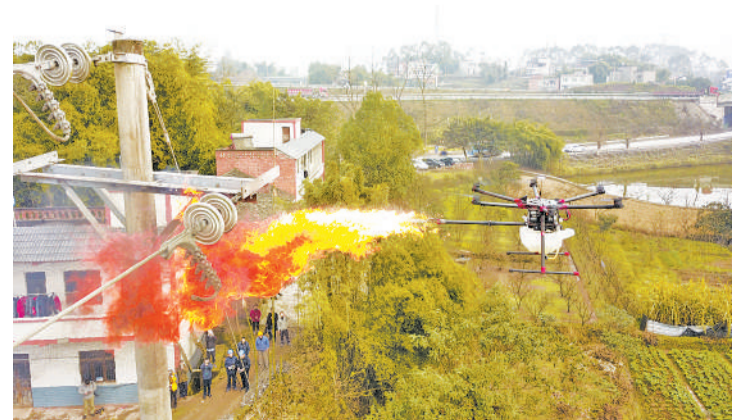
重庆首台喷火清障无人机日前在国家电网重庆永川供电公司正式投用。这台多旋翼无人机通过搭载带有燃料箱、油泵、自动点火装置的喷火吊舱任务模块,可以对影响高空电力线路安全的飘挂物进行定点清除作业。 新华社记者 刘 涛摄
