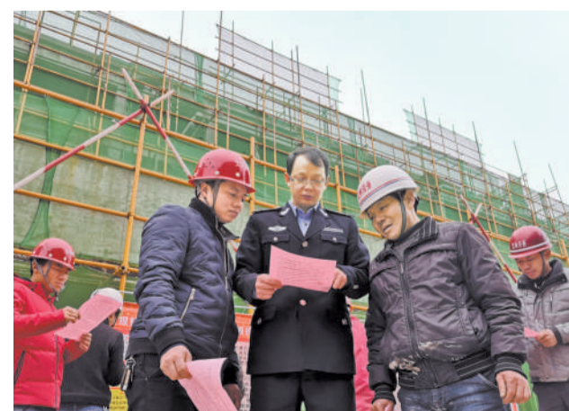
1月18日，江西省宜春市袁州区劳动监察局工作人员来到润达美墅项目建设工地，给农民工宣传劳动法律法规等内容，并提醒施工单位及时足额发放农民工工资。
