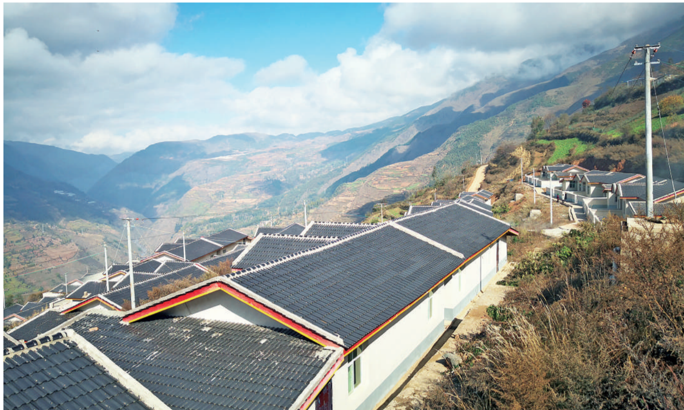
近年来，四川凉山州昭觉县大力开展易地扶贫搬迁工程，让许多贫困群众住上了好房子。图为塘且乡呷姑洛吉村71户贫困群众的新住房。阿克鸠拍摄
