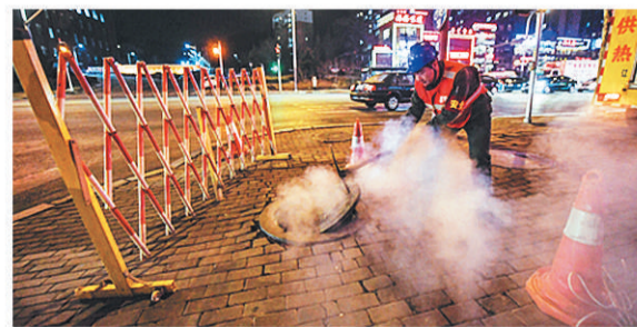
日前,供暖管道检修工在大连市沙河口区南沙街一处检测井作业。新华社记者 潘昱龙摄
