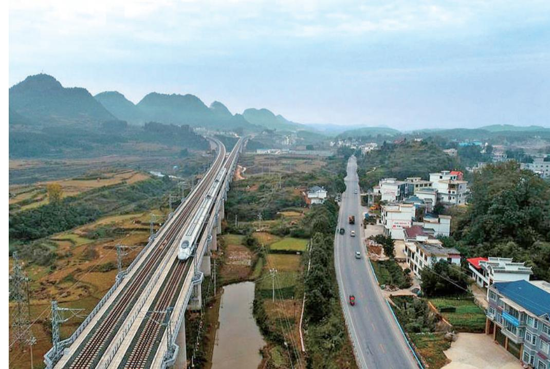
10月30日,动车组列车在铜玉铁路上运行。当日,贵州省铜(仁)玉(屏)铁路进入动车组列车运行试验阶段,离正式开通投用又近一步。铜玉铁路于2013年12月份开工建设,线路全长47.7公里,设计时速200公里,有望于2018年底开通运营。本报记者 吴秉泽摄
