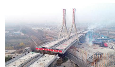
10月25日，唐山市二环路项目上跨津山铁路斜拉桥转体成功。该桥总长927.5米，主桥由斜拉转体桥和转体T构桥组成。
