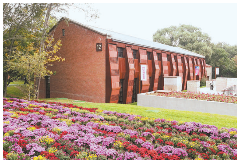
吉林省长春市水文化生态园日前落成。该园前身是始建于1932年的长春市第一净水厂。长春市积极开展保护性建设,对园区内历史遗迹和具有近百年历史的12座文保建筑、历史建筑采取“修旧如旧”的办法进行升级改造,不但保留了城市供水历史印记,也为展示城市水文化发展变迁提供了绝佳素材。图为水文化生态园一角。本报记者 李己平摄
