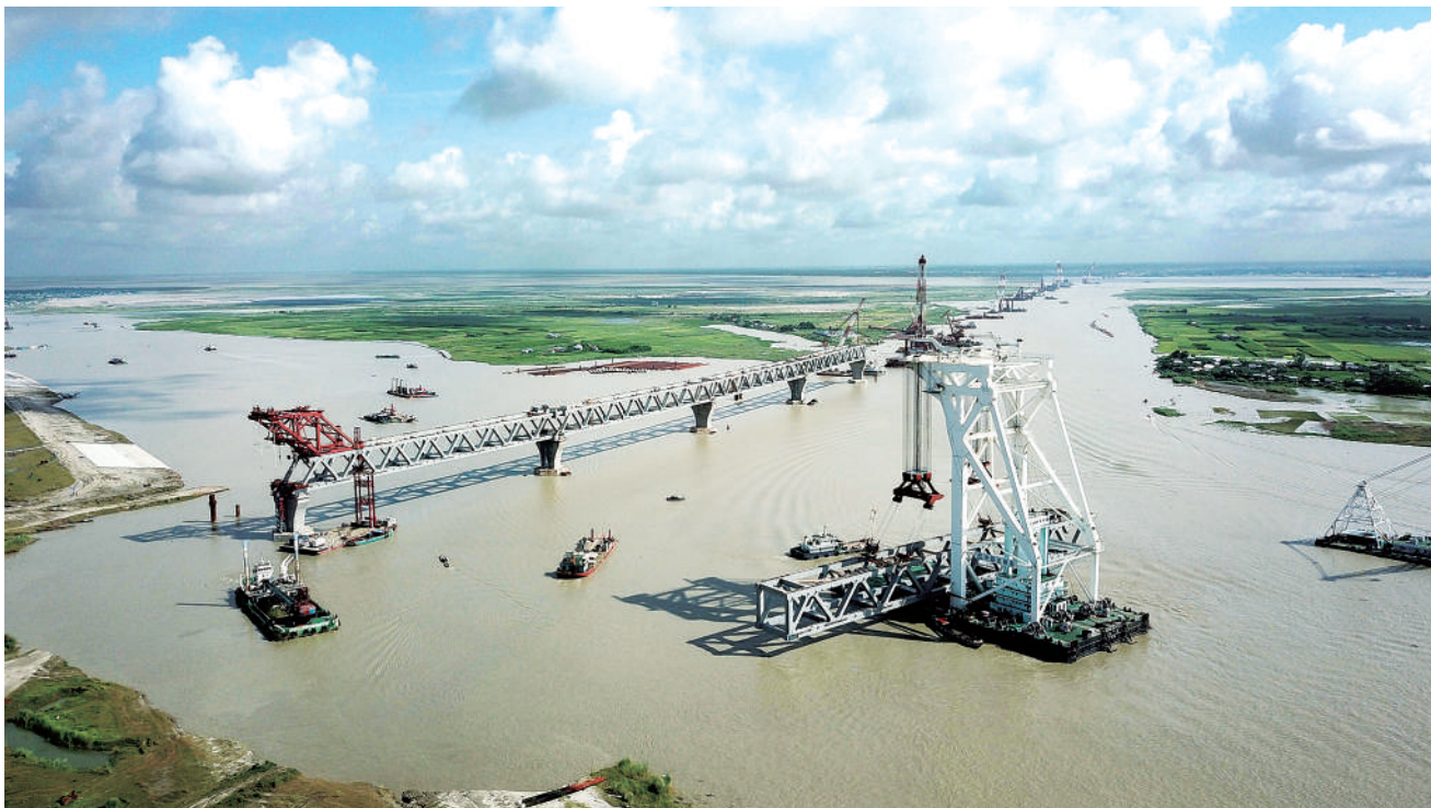
孟加拉当地时间10月14日，由中铁集团承建的孟加拉帕德玛大桥铁路连接工程开工。图为帕德玛大桥在架设钢梁。张静摄
