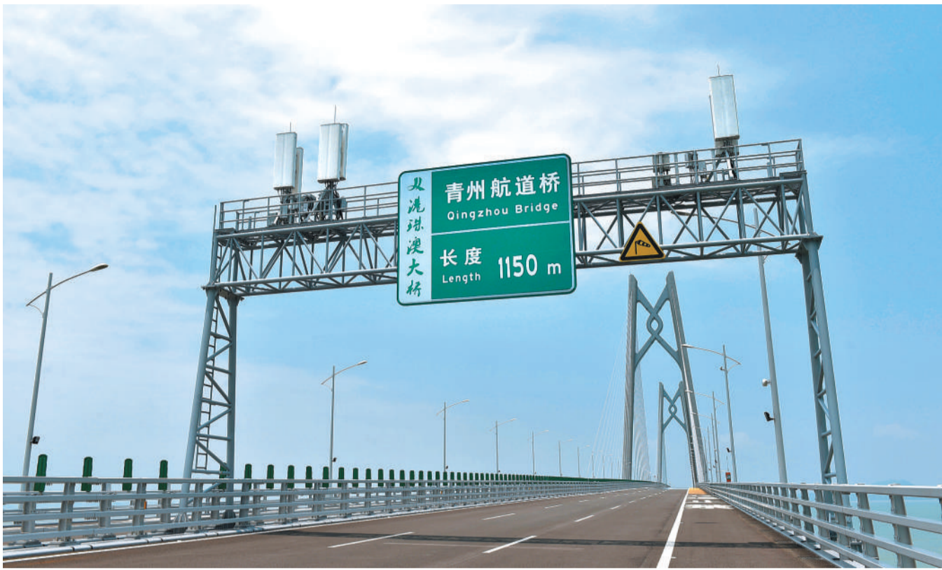
图为设置在港珠澳大桥龙门架上的高增益天线。由中国铁塔广东省分公司承建的港珠澳大桥移动通信基础设施与港珠澳大桥实现同步规划、同步设计、同步建设，紧密融合。
