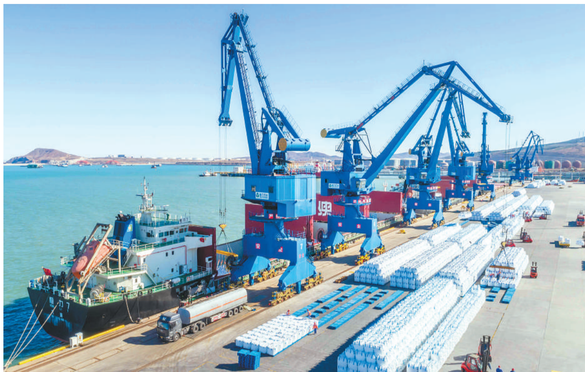
图为大连市重点项目恒力石化10万吨液体码头。
