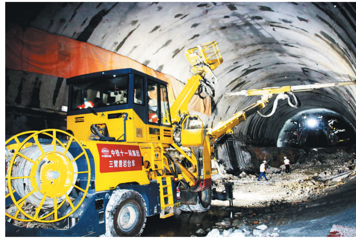
9月27日，中铁路十一局贵(阳)南(宁)高铁广西段都安隧道出口，全智能三臂凿岩台车正在作业。贵南高铁是国家中长期铁路网规划“八纵八横”高铁主通道包头至海口通道的重要组成部分，线路北起贵阳北站，终至南宁东站，线路全长533公里，设计时速350公里，预计2023年12月建成通车。都安隧道地质结构复杂，是全线重难点工程之一，也是全线机械化施工的样板。 郑传海摄
