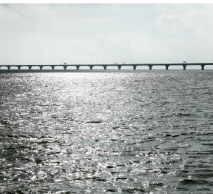
据悉,处于“山竹”中心风圈范围内的港珠澳大桥情况正常,经受住了检验。这是继“天鸽”“帕卡”之后,港珠澳大桥第三次接受强台风考验。(新华社发)
