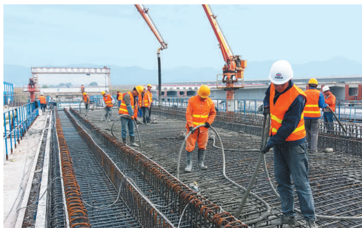
京张高铁崇礼支线上，中铁二十局二公司建设者在浇筑最后一批32米单线箱梁（9月18日摄）。日前，北京2022年冬奥会重点配套工程——京张高铁崇礼支线高质量完成519孔箱梁预制任务。崇礼支线2019年底建成后，将与京张高铁主线共同形成北京至张家口太子城奥运村最便捷的客运通道。曲志忠摄
