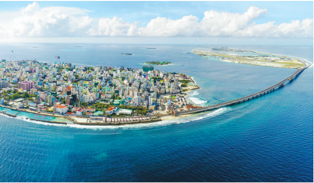
马尔代夫首都马累岛通过中马友谊大桥与机场岛实现连接。大桥全长2000米,跨海桥梁1390米,其中主桥长为760米,为六跨叠合混合梁V形钢结构。 王明亮摄
