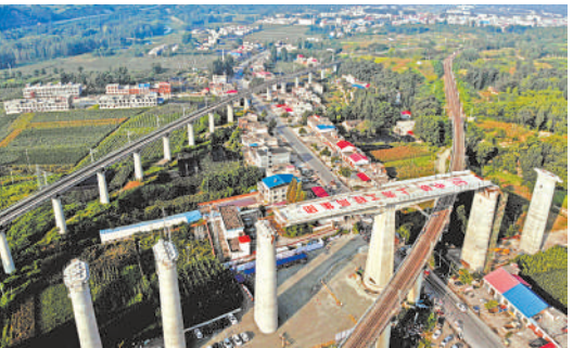
△8月14日,蒙华铁路峡河特大桥跨越宁西铁路曲线梁转体成功。蒙华铁路峡河特大桥位于河南省南阳市境内,全长879米。蒙华铁路北起内蒙古鄂尔多斯,终至江西吉安。(新华社发)
