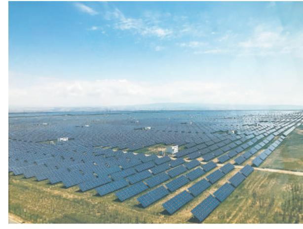
图为位于青海省海南藏族自治州共和光伏产业园的水光互补光伏电站。该电站由国家电力投资集团黄河上游水电开发有限公司建成，装机容量为85万千瓦，是目前全球最大的水光互补项目。
